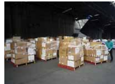
余震による荷崩れを防ぐため、ラップを巻いて固定(現地倉庫も被災:写真右上)
