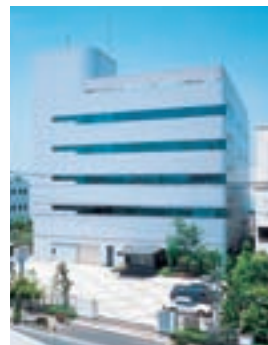
エムアンドシーシステム（システムセンター）
